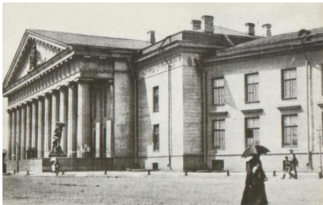
Рис. 1. Фасад Института корпуса горных инженеров, середина XIX века
